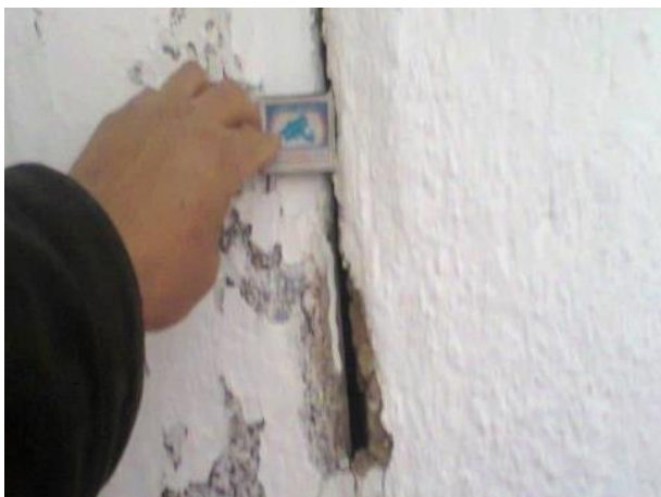
Фото 2. Трещина и вывал штукатурки в стене между комнатами в доме ( N 42^{\circ}05'02,0'' ; E 77^{\circ}14'16,8'' ; alt. 2437 м ул. Достук 6)
