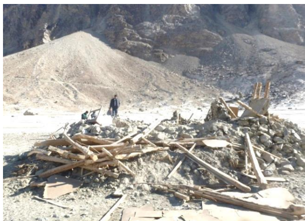
Рисунок 3. Разрушенные жилые дома каменной постройки в кишлаке Гудара
