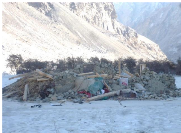
Рисунок 3. Разрушенные жилые дома каменной постройки в кишлаке Гудара
