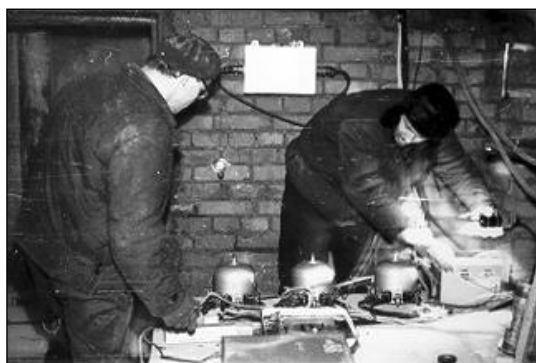
а) монтаж сейсмоприемников комплекса КОД в шахте, 1965 г. [9];
